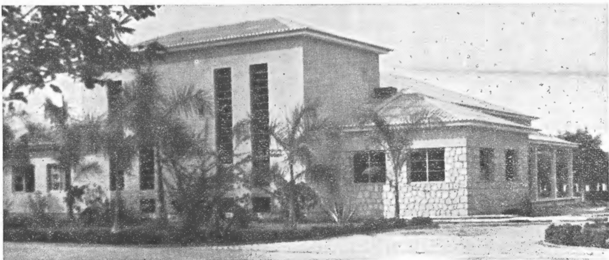
O «Centro Cultural e Recreativo» da Casa do Gaiato de Benguela — em fase de acabamentos.
